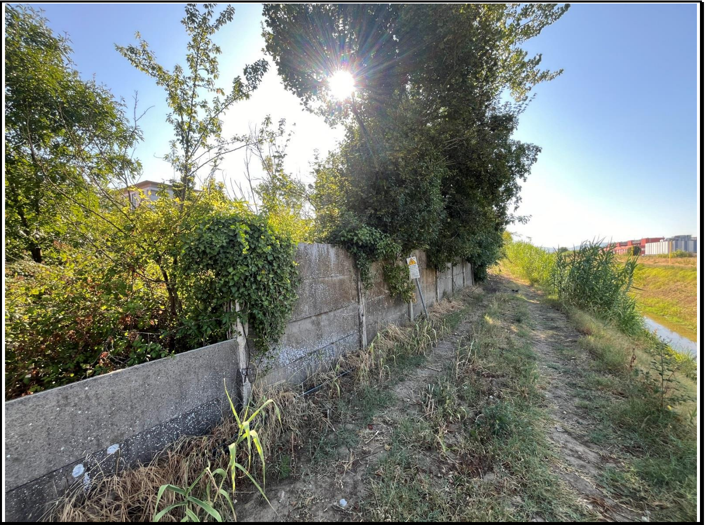
Foto n. 5 Vista dell'area edificabile dalla sponda del torrente Zambra
