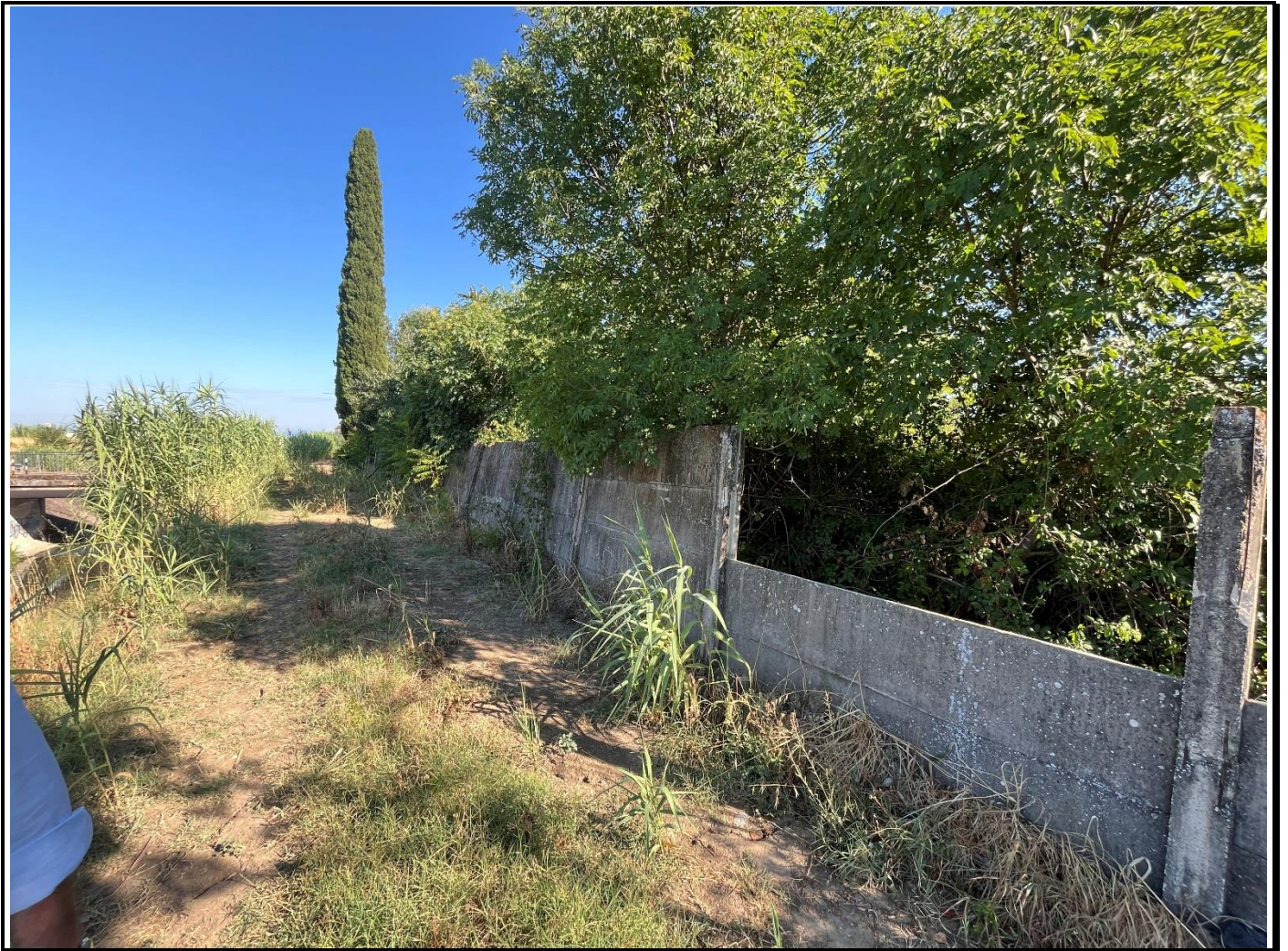
Foto n. 4 Vista dell'area edificabile dalla sponda del torrente Zambra
