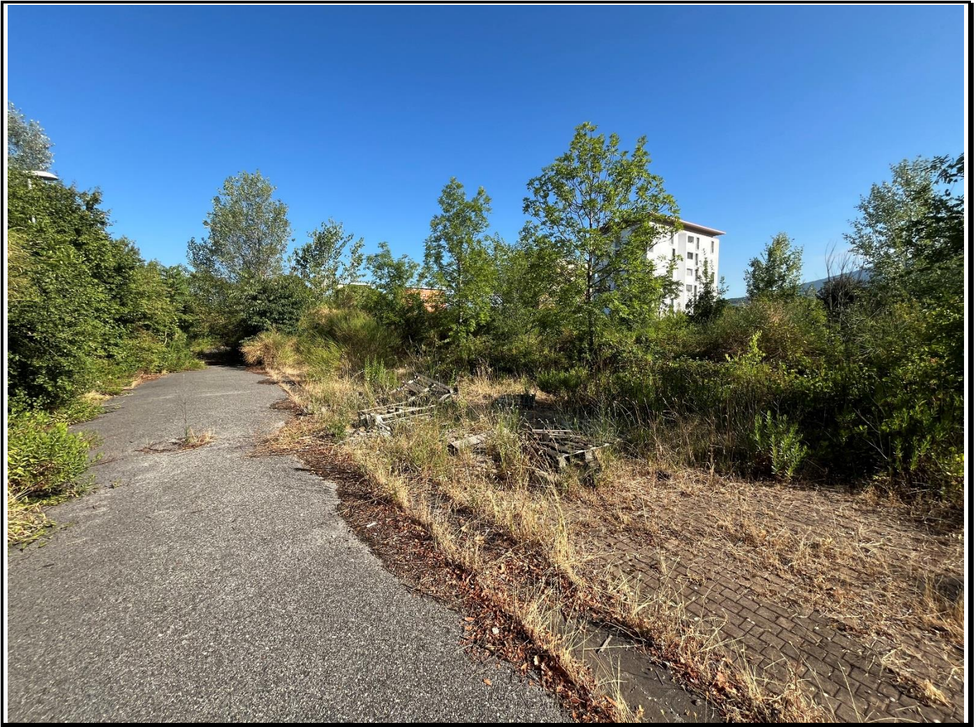
Foto n. 9 Porzione dell'area edificata in stato di abbandono
